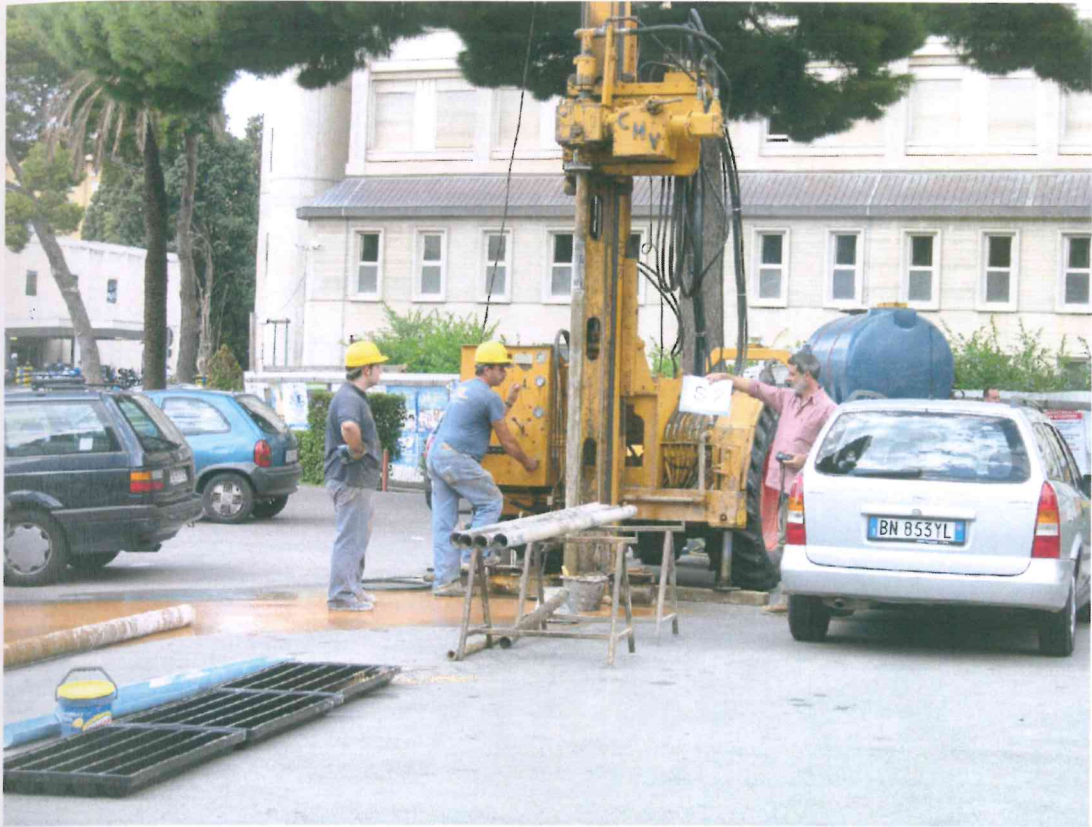
Postazione sondaggio S-2
