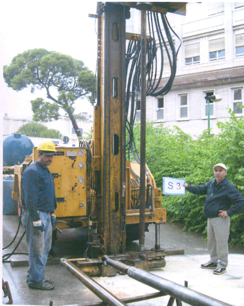
Postazione sondaggio S-3
